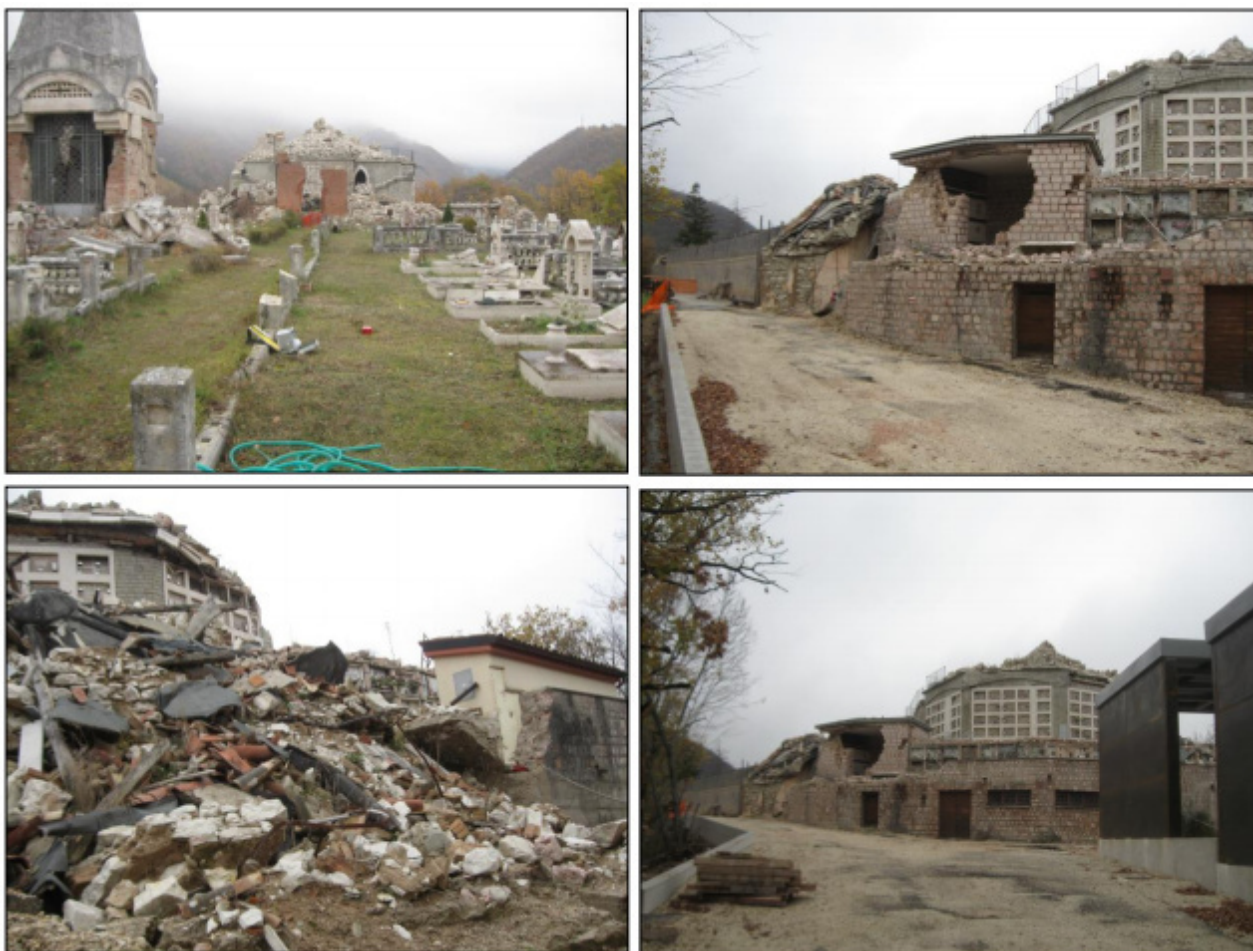
Alcune immagini del cimitero dopo il sisma
