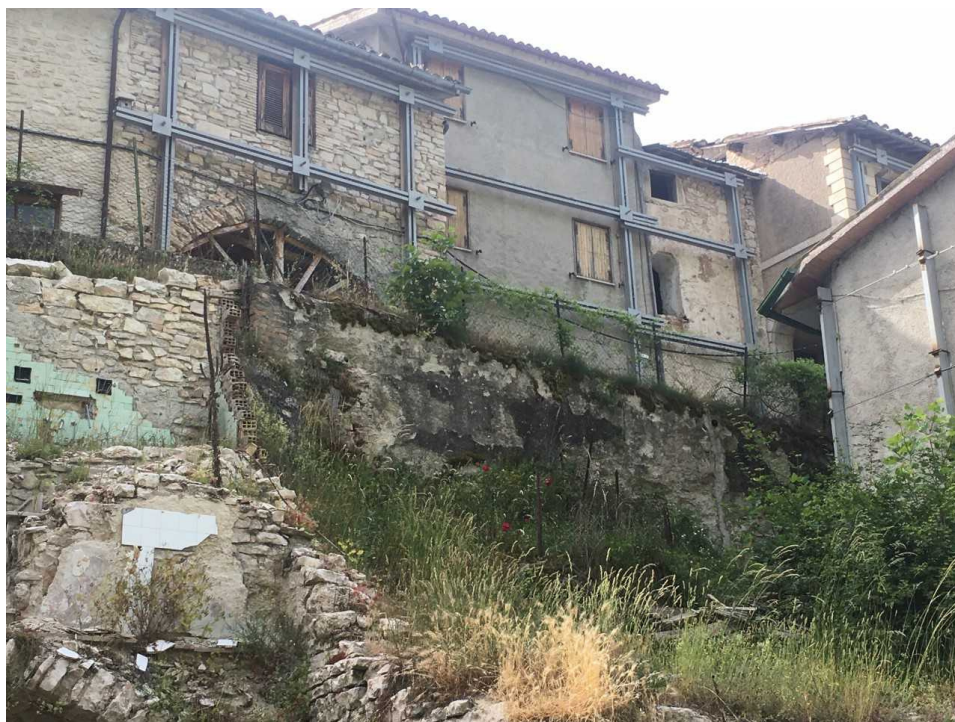
Sistema dei muri di sostegno dei terreni e della viabilità pubblica a Vallestretta
