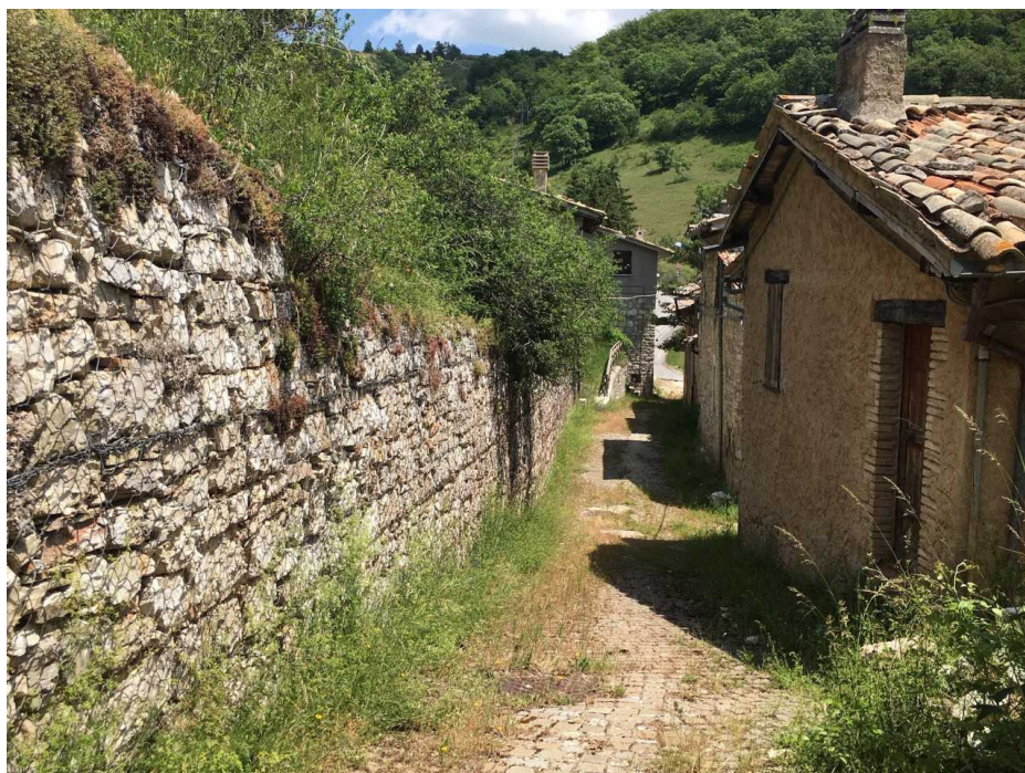
Sistema dei muri di sostegno dei terreni e della viabilità pubblica a San Placido
